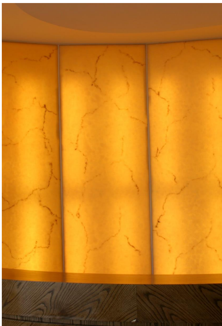
Retroilluminazione ottenuta con tubi a fluorescenza. Risultato non omogeneo.
