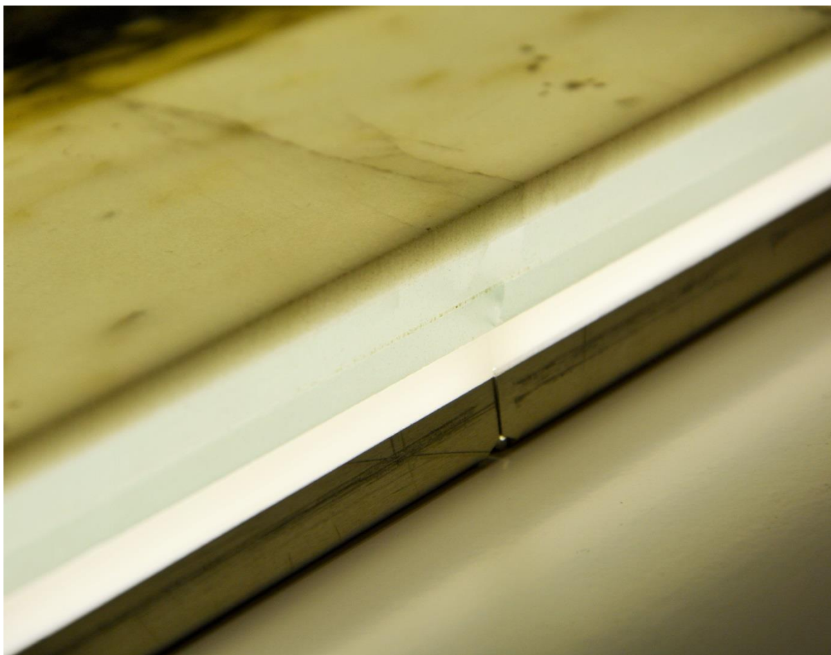
Particolare lastra di marmo retroilluminata da più pannelli LED. Omogenea la traslucenza ottenuta.
